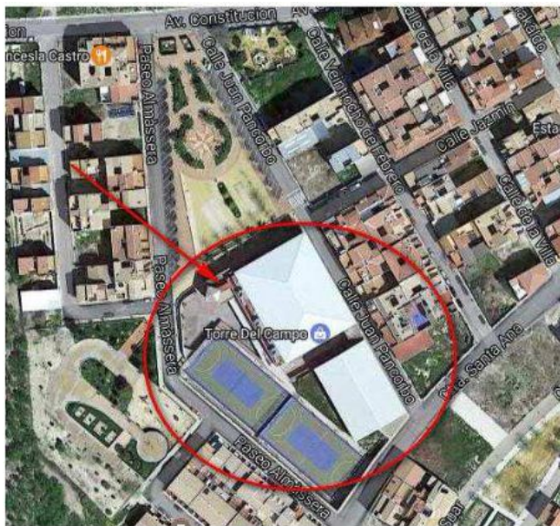
Complejo polideportivo "28 de Febrero", Paseo de Almassera S/N Torredelcampo
